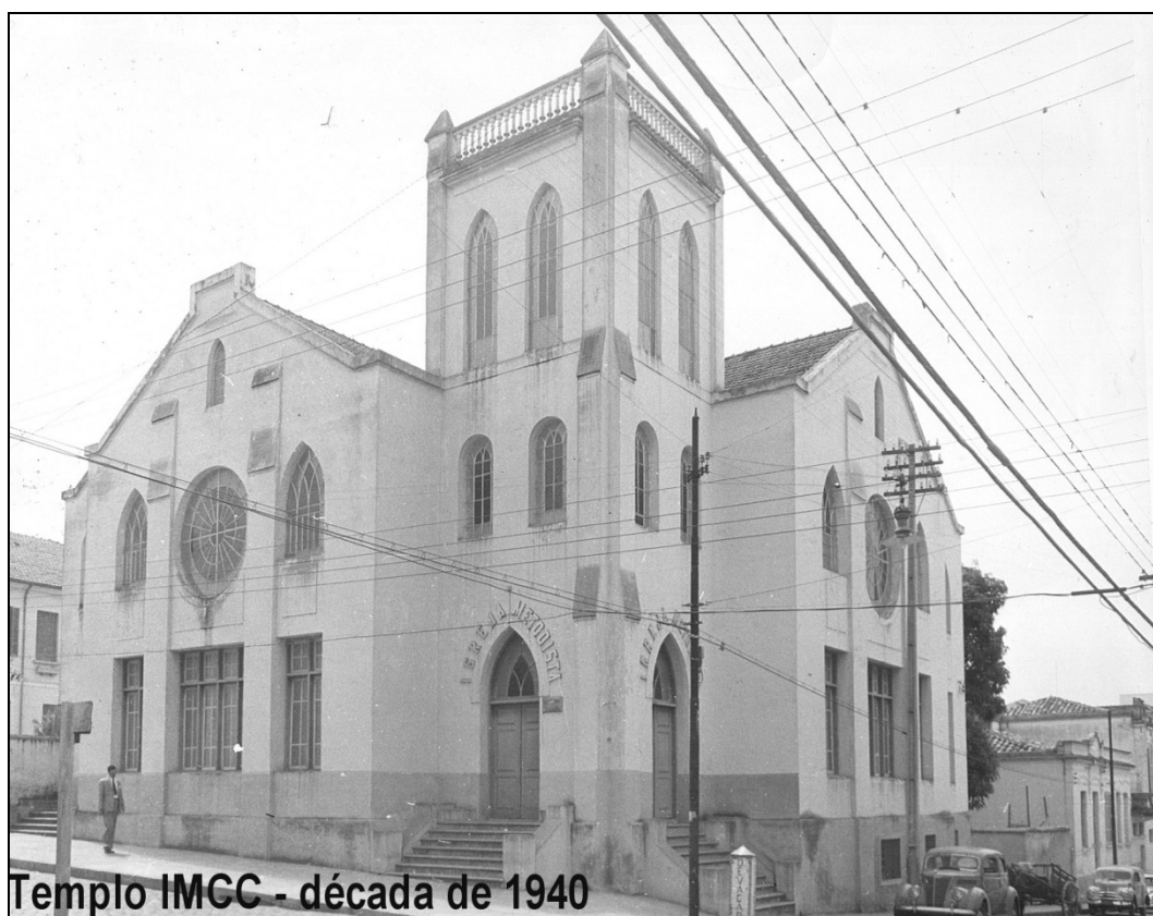
Figura 127– Tomada exterior da Igreja Metodista Central em Campinas (ESTRADA, 2004, foto templo 07)
