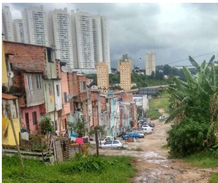
Imagem 9- Esgoto a céu aberto no DER
