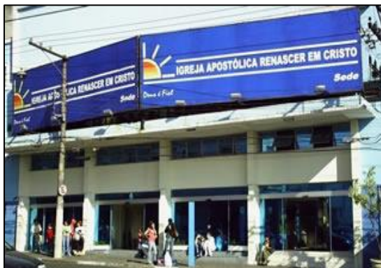
Figura 38 Fachada IARC – Sede - 2000
