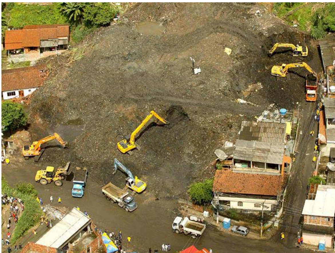
Fotografia 2. Equipamentos trabalhando nos escombros no Morro do Bumba em Niterói (RJ) Fonte: AGÊNCIA ESTADO (Banco de Imagens) 15
