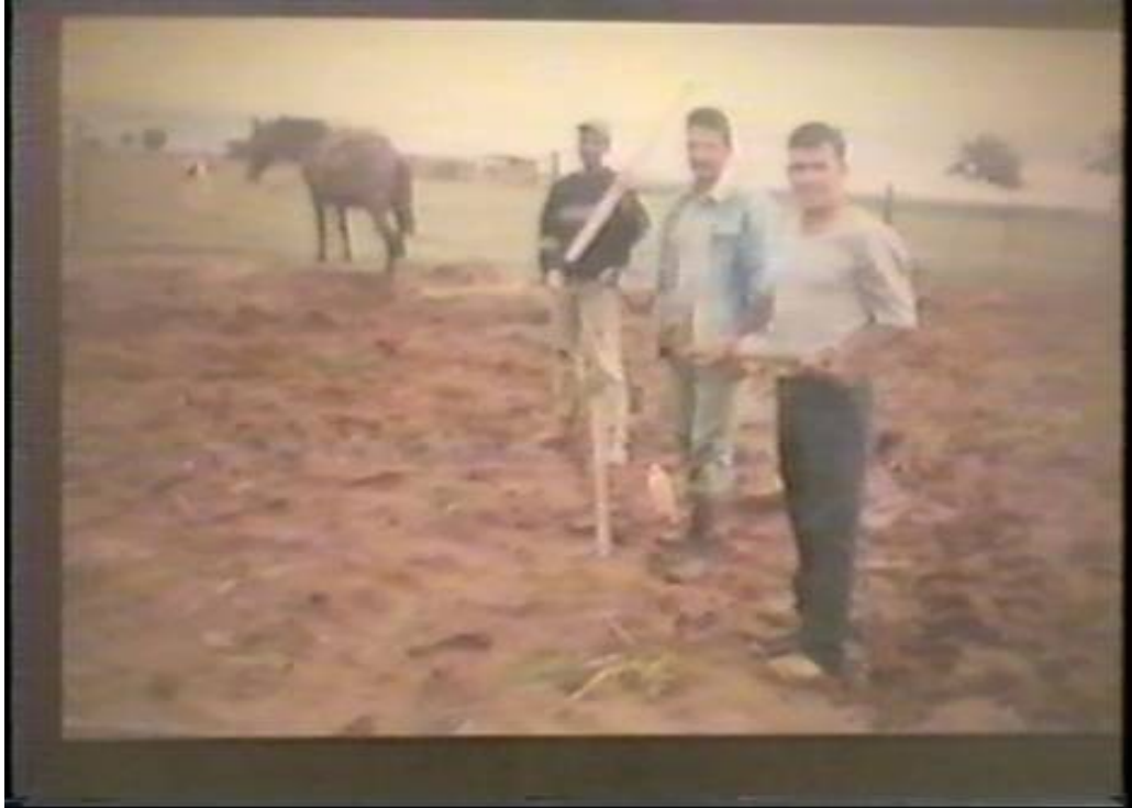
(ordem da direita para a esquerda: Gerson, Sidnei, Gustavo: medindo o terreno para a construção da congregação “Monte Sião”)
