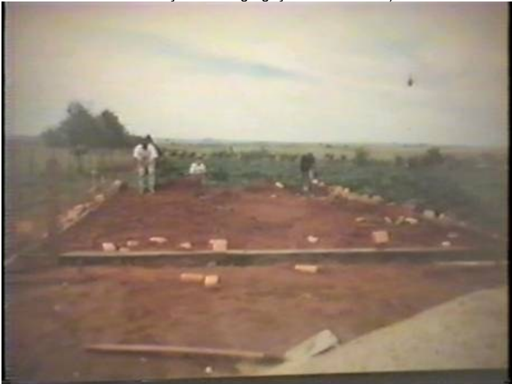
(assentando o alicerce após o aterro realizado pela prefeitura de Mirante do Paranapanema)
