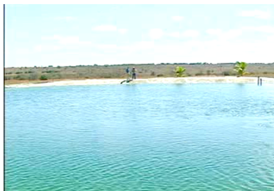
Um dos dois reservatórios -7 milhões de litros cada
