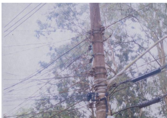
Fotos 3.5 e 3.6: Não há eletricidade instalada na rede elétrica; moradores fizeram “gatos”
