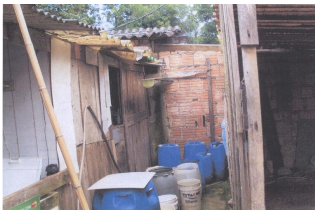
Foto 3.4: Na falta de água encanada, os moradores captam água da chuva como água potável
